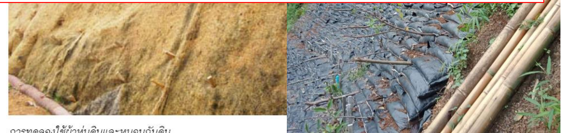
การทดลองใช้ผ้าห่มดินและหมอนกั้นดิน
